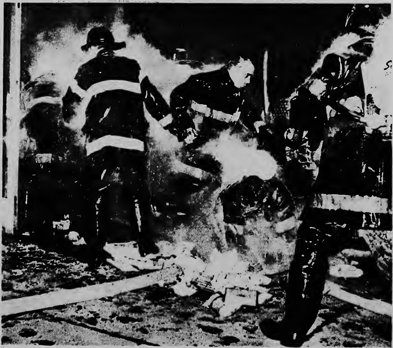
Riba e foto aki nos ta mira con e teniente bombero di ciudad di New York, John Roche, ta caiendo riba su rudia. Su cara ta kimá y su jas ta kimando, despues qu el a ser forsa di corre sali or di un supermarket na Bronx, debido na e intenso calor. E bombero John O' Malley tambe a sali na carreda su tras, cu su pafanan na candela. E tambe a haña quemadura na su cara.
